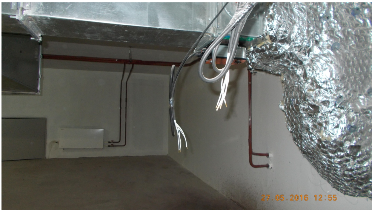
Фототаблица № 1.3. Ярцевская, д. 32, подъезд №1
